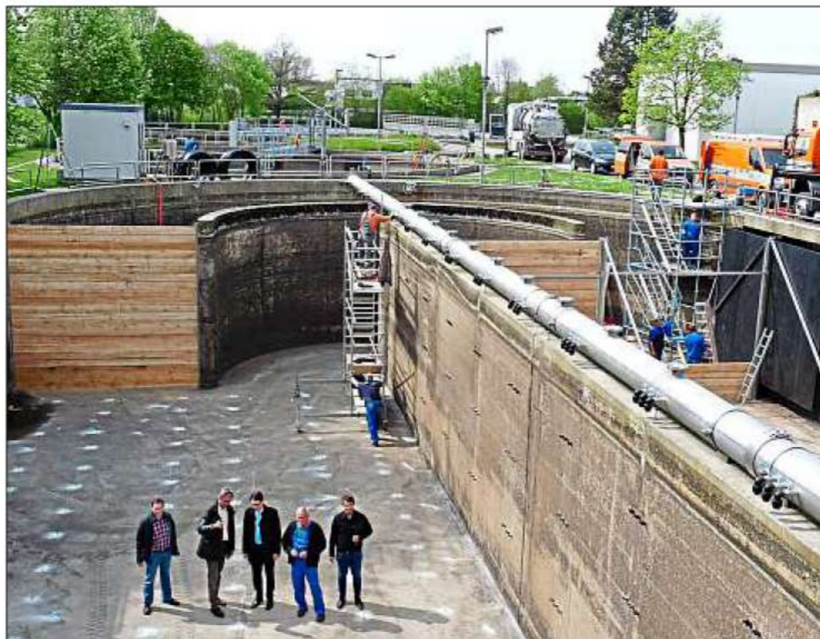
Selten möglich – ein Ortstermin im leeren Klärbecken. OB Christian Moser mit Uwe Handrick vom Tiefbauamt und Alfons Strasser sowie Vertretern des Planungsbüros WipflerPlan und der ausführenden Firma Scharr Tec. – Foto: Eichwald
