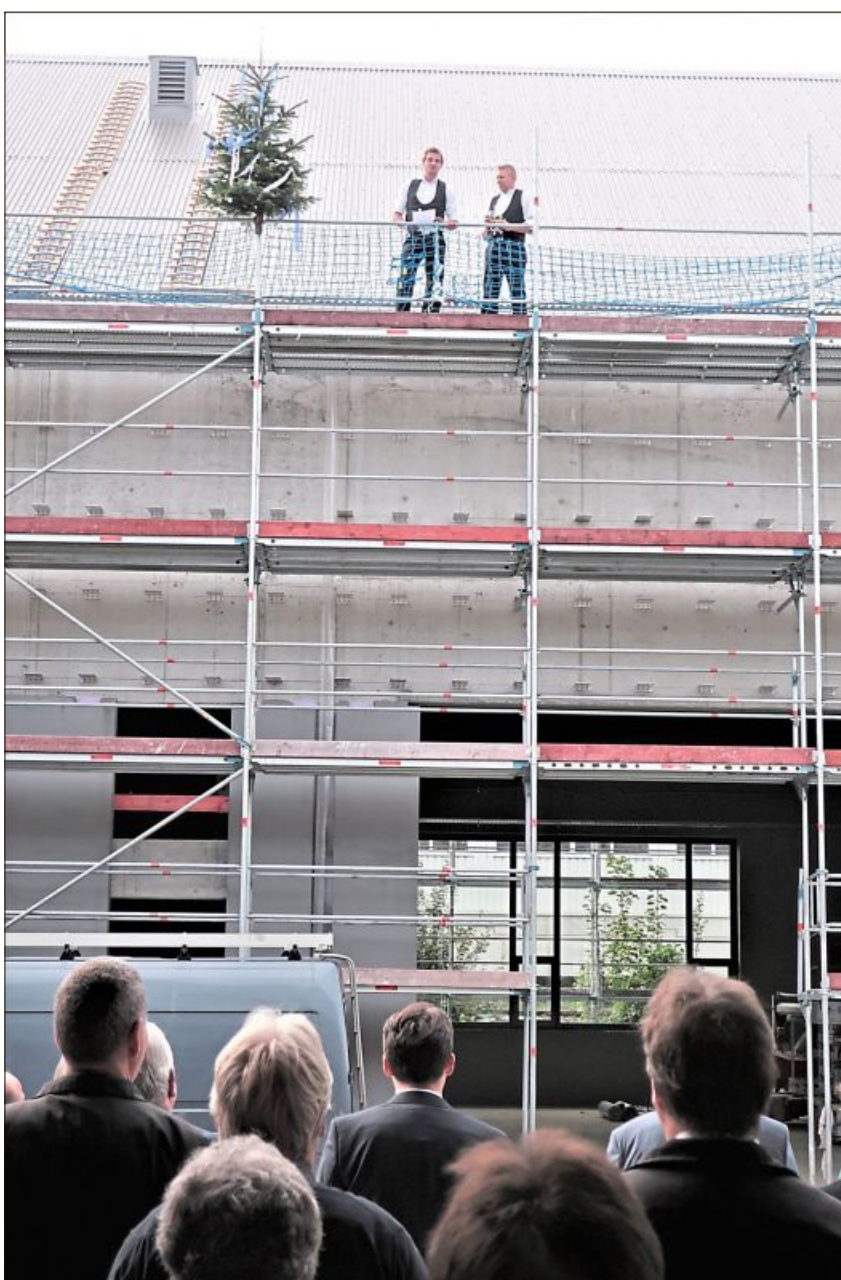
Nach alter Tradition wurde in luftiger Höhe der Richtspruch vorgetragen.
