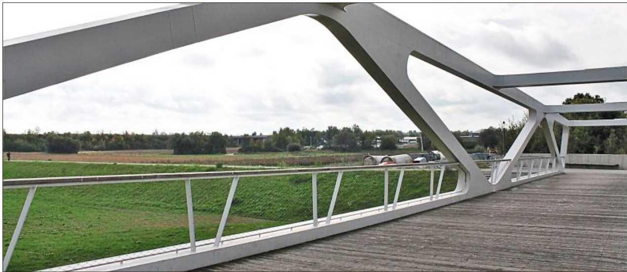
„Immersbühl“ von der Fußgängerbrücke aus gesehen: Hier soll ein „Stück Stadt“ entstehen, wie Bauamtsleiter Strasser es formulierte.
