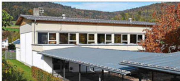
Die Mietrachinger Turnhalle bekommt einen Anbau, in dem Garderoben, Toiletten und eine Küche für die Nutzung als Veranstaltungssaal untergebracht werden. – Foto: Binder
